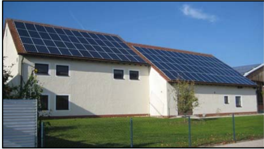
PV auf der Wasserversorgung Beilngries 29,82 kWp
