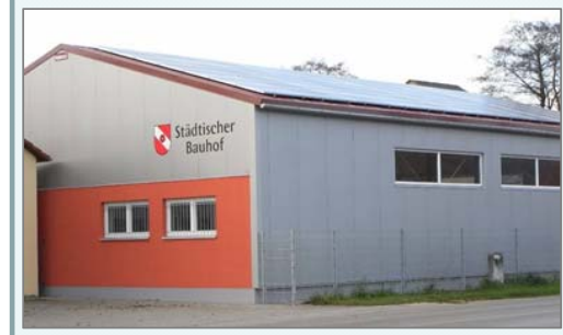
PV auf der Bauhofhalle Dietfurt 38,5 kWp
